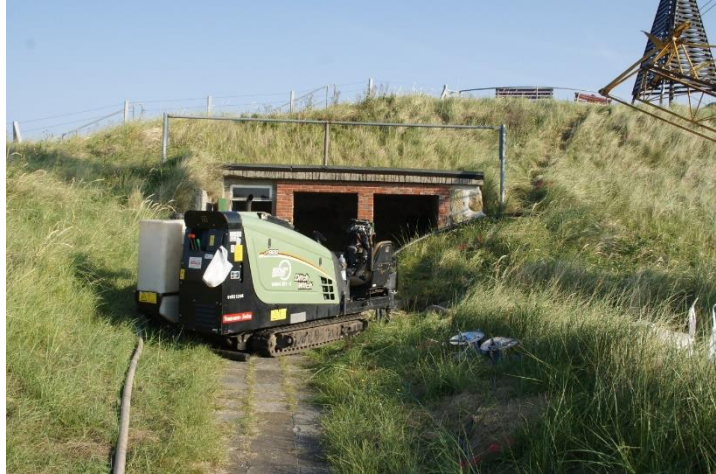
Horizontalbohrung Schutzdüne
